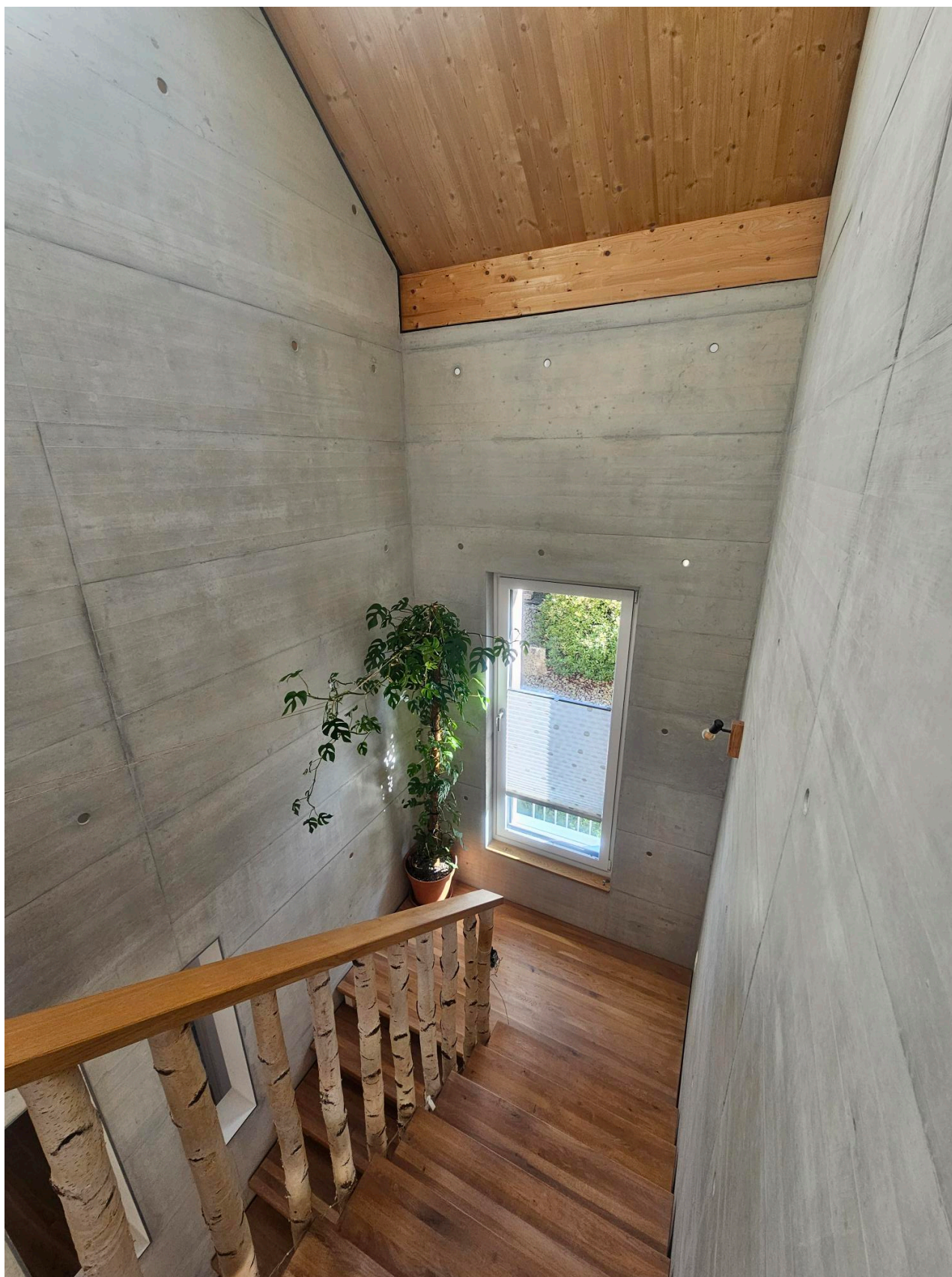
Treppenabgang Obergeschoss in das Erdgeschoss. Alle Schalungsbinder wurden mit rostfreien Abdeckungen versehen.
